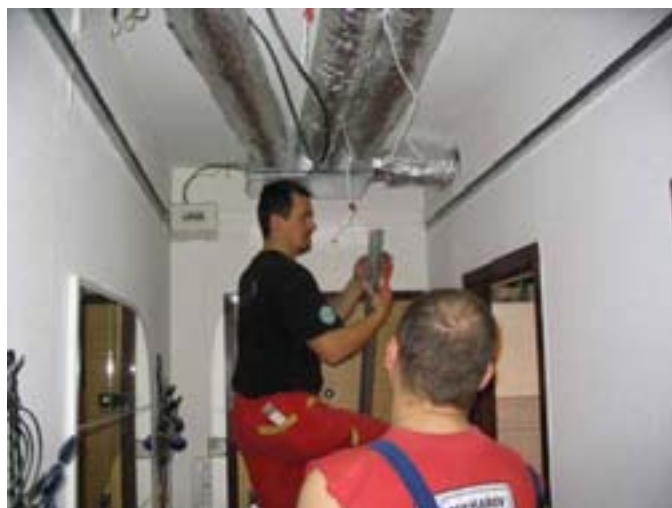
Detail přípravy konstrukce podvěšeného sádrokartonového podhledu pro zakrytí VZT rozvodů v chodbě. Zároveň provedena příprava pro osazení bodových světel do budoucího podhledu
