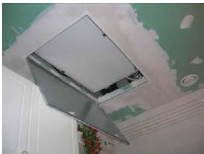
Dokončení podhledu v koupelně – příprava pro malbu. Na přání investora byly osazeny další dveře pro celkové zakrytí jednotky.
