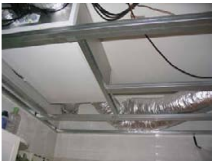
Detail konstrukce podvěšeného sádrokartonového podhledu v koupelně po instalaci VZT rozvodů, kde v této realizaci byla umístěna jednotka DUPLEX 220
