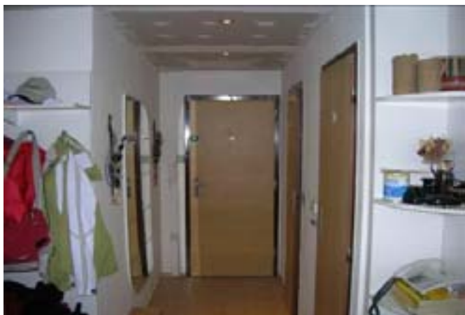
Pohled na chodbu po dokončení podhledu (příprava pro malbu). Ve středu stropu bodové osvětlení.
